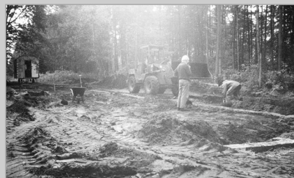
Fundamente des Waschraums treten zutage
