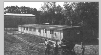
Im Jahre 1932 wurde die spätere KZ Baracke von der „Evangelischen Freischar der Arbeit“ errichtet.
