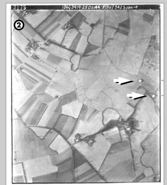
Ausschnitt aus der Aufnahme vom 25.12.1944. Am rechten Rand 2 Flug- zeughallen im Bau.
